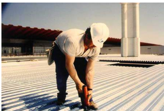
Foto nº 4.2: Utilización de herramientas en la realización de fijaciones
