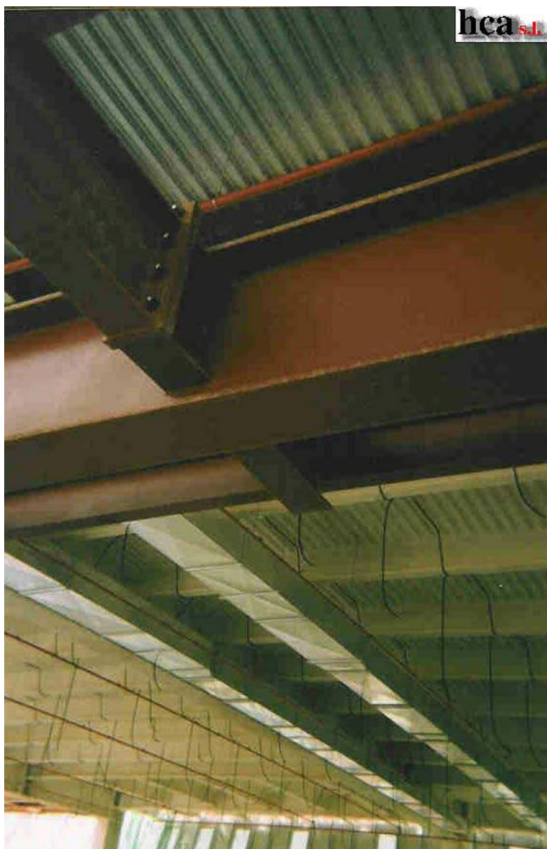
Foto nº 5. 4: Protección "gunitada", parcialmente ejecutada.
