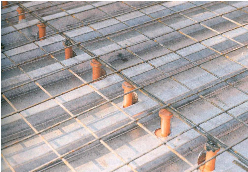
Foto 1: Forjado mixto de chapa colaborante con vigas mixtas antes del hormigonado (Foto: Michel Crisinel, ICOM-EPFL)
