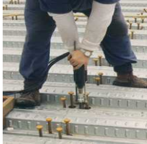
Foto nº 3.9: Colocación de conectores.
