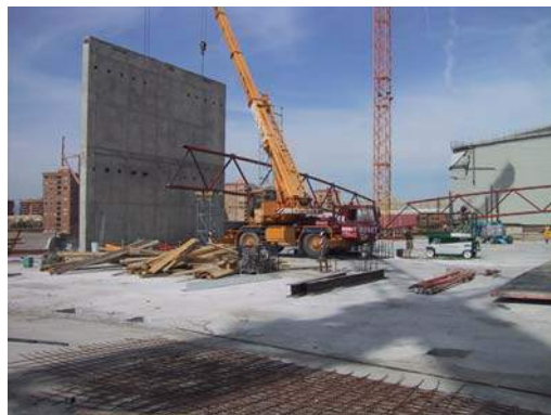
Figura 17: Cargas provisionales sobre el forjado mixto
