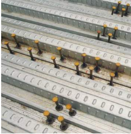
Foto nº 3.9: Colocación de conectores.
