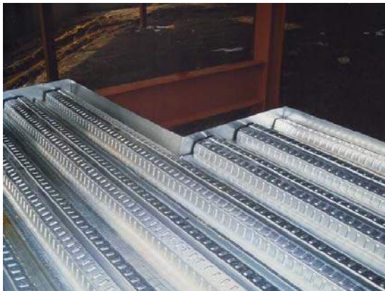
Foto nº 3.12: Perfiles metálicos utilizados para remate perimetral
