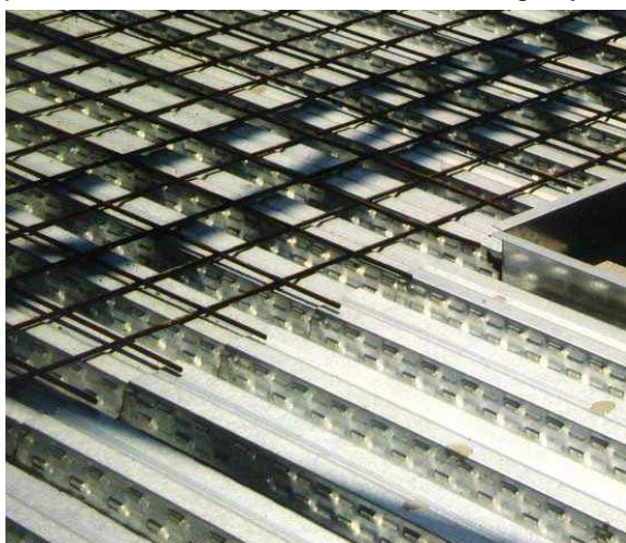
Foto nº 4.4. Actuación de la armadura
