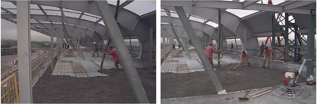
Foto nº 4.5: Hormigonado por bombeo
