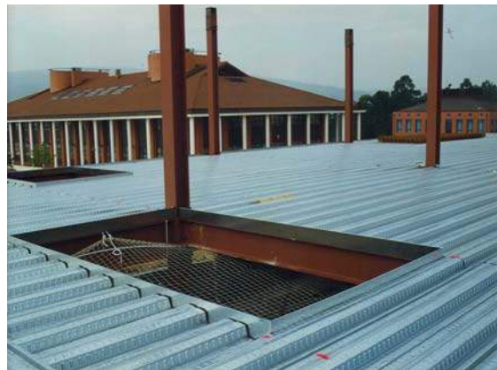
Foto nº 3.12: Perfiles metálicos utilizados para remate perimetral
