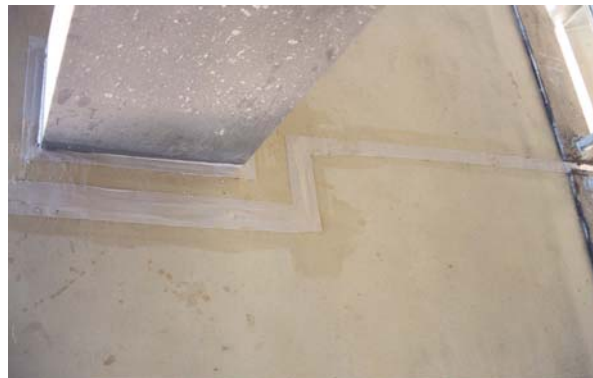
Figura 13: Junta de dilatación en la zona del aparato de apoyo de un pilar de cubierta
