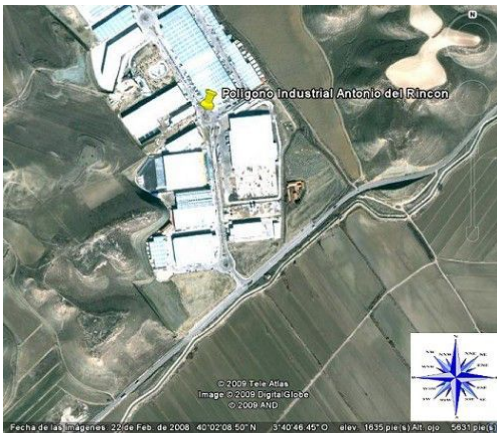
Figura 12: Polígono Industrial Antonio del Rincón.
