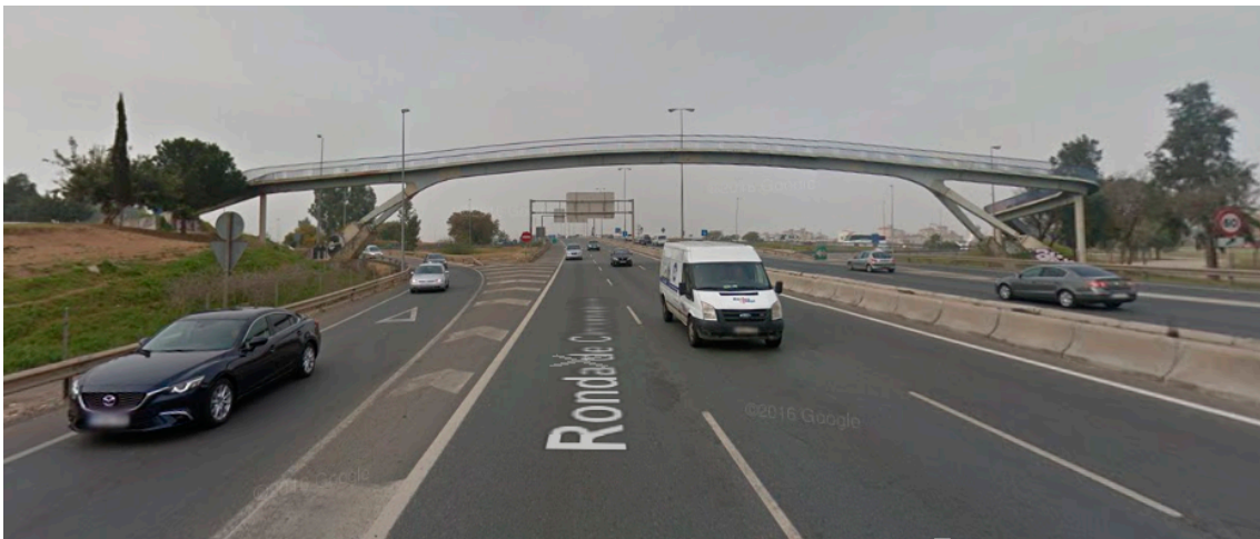
Figura 9. Pasarela a la altura del cruce de la SE-30 con carretera de Utrera
