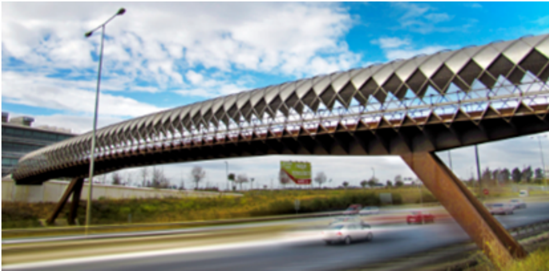
Figura 8. Pasarela a la altura del centro tecnológico Palmas Altas. Luis Vidal, arquitecto. 2012
