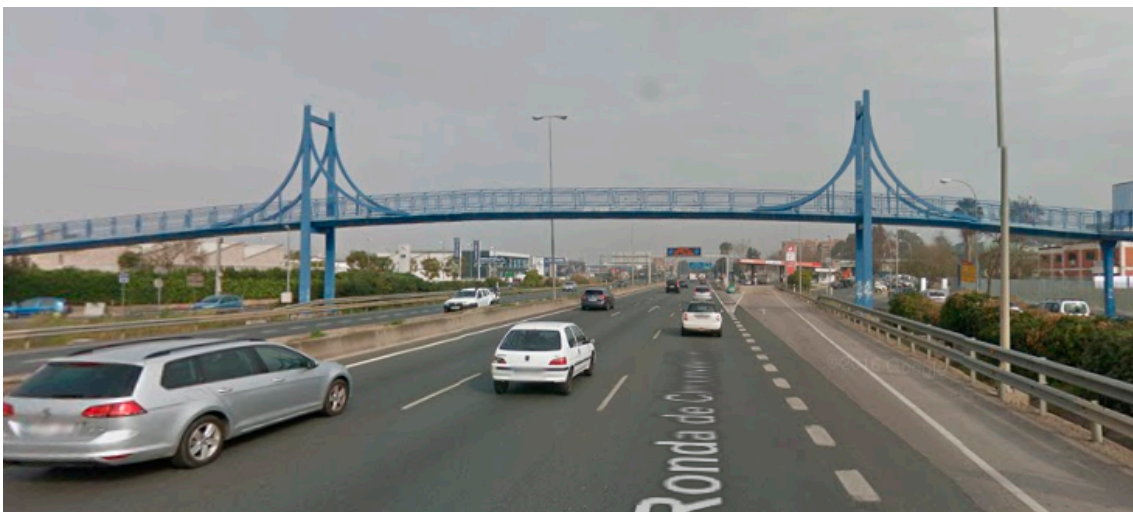
Figura 10. Pasarela a la altura del cruce con la calle Carlos Serra y Pickman
