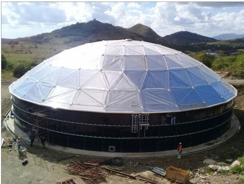
Ilustración 4. Tanque fijo de techo domo
