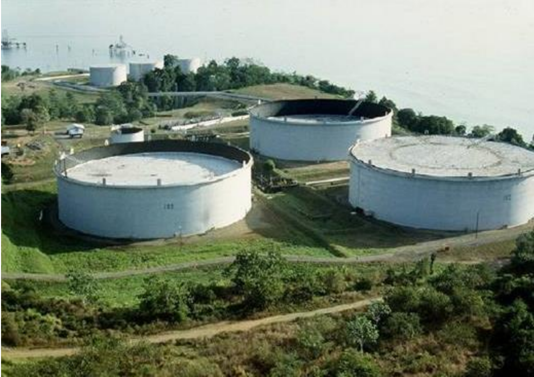
Ilustración 5. Tanque de techo flotante
