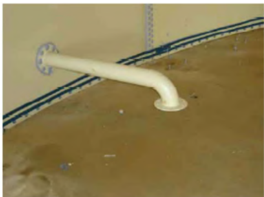
Ilustración 1.7.3.2-6 Hydrotite colocado antes de la 2ª fase de la losa
