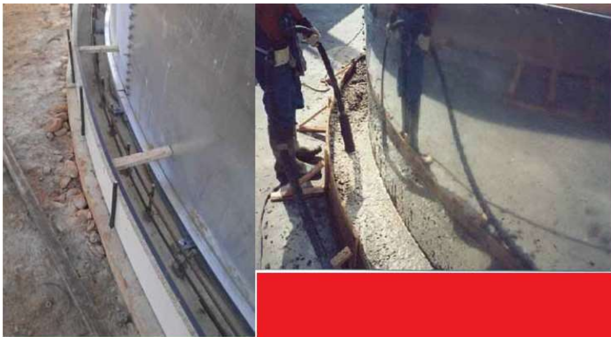
Ilustración 1.7.3.2-7 Hormigonado 2ª fase exterior.
