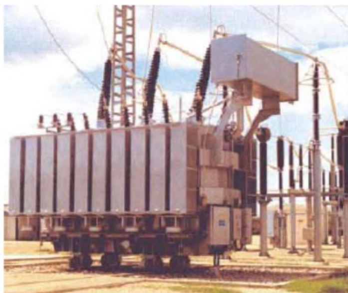
Ilustración 1.5.3.1-2 Transformador de aceite con depósito
