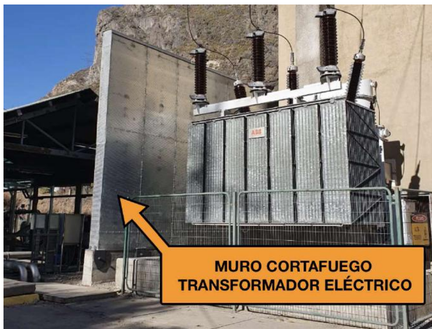
Ilustración 1.6.6.1-1 Muro cortafuego transformador interperie
