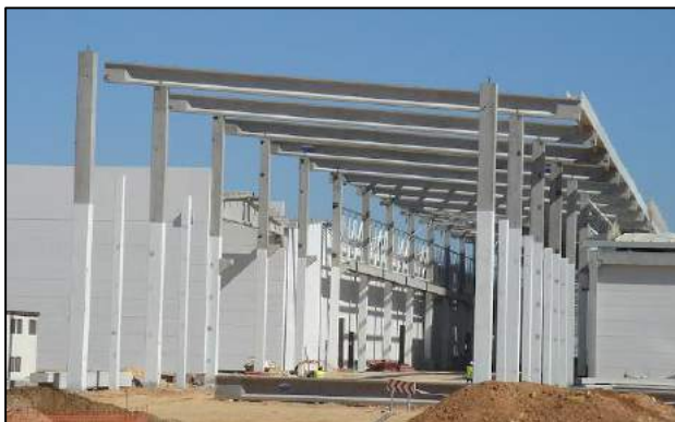
Imagen 1.3. Nave hormigón prefabricado
